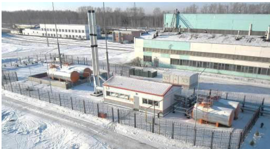
Рис. 1. Газовая блочно-модульная котельная станция Черепаново
