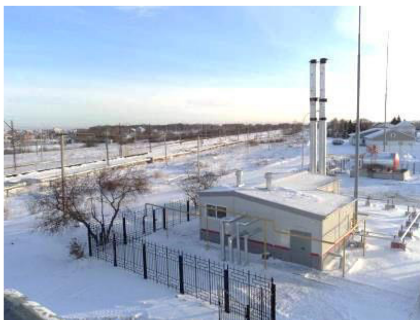
Рис. 2. Автоматизированная блочно-модульная котельная станция Входная
