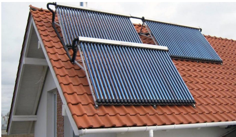
Рис. 1. Вакуумный солнечный коллектор
