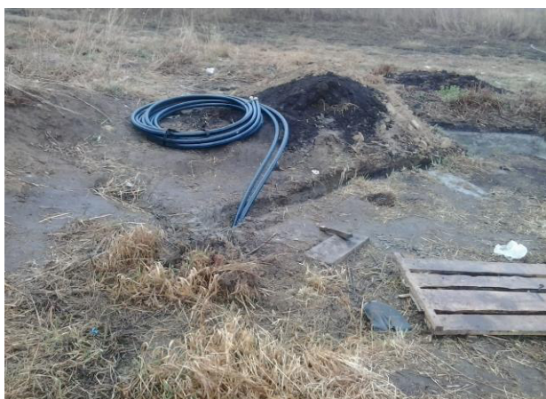
Рис. 2. Геотермальный зонд, коллектор внешнего контура
