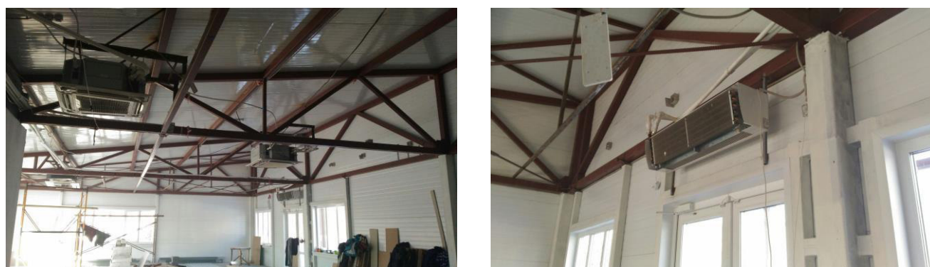
Рис. 4. Контур отопления, фанкойлы и тепловые завесы
