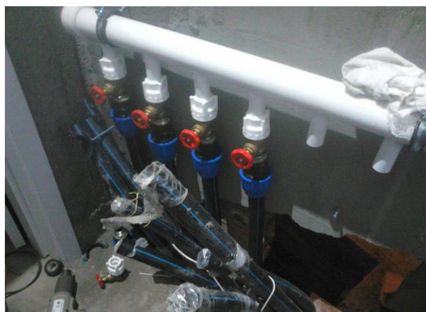
Рис. 2. Геотермальный зонд, коллектор внешнего контура
