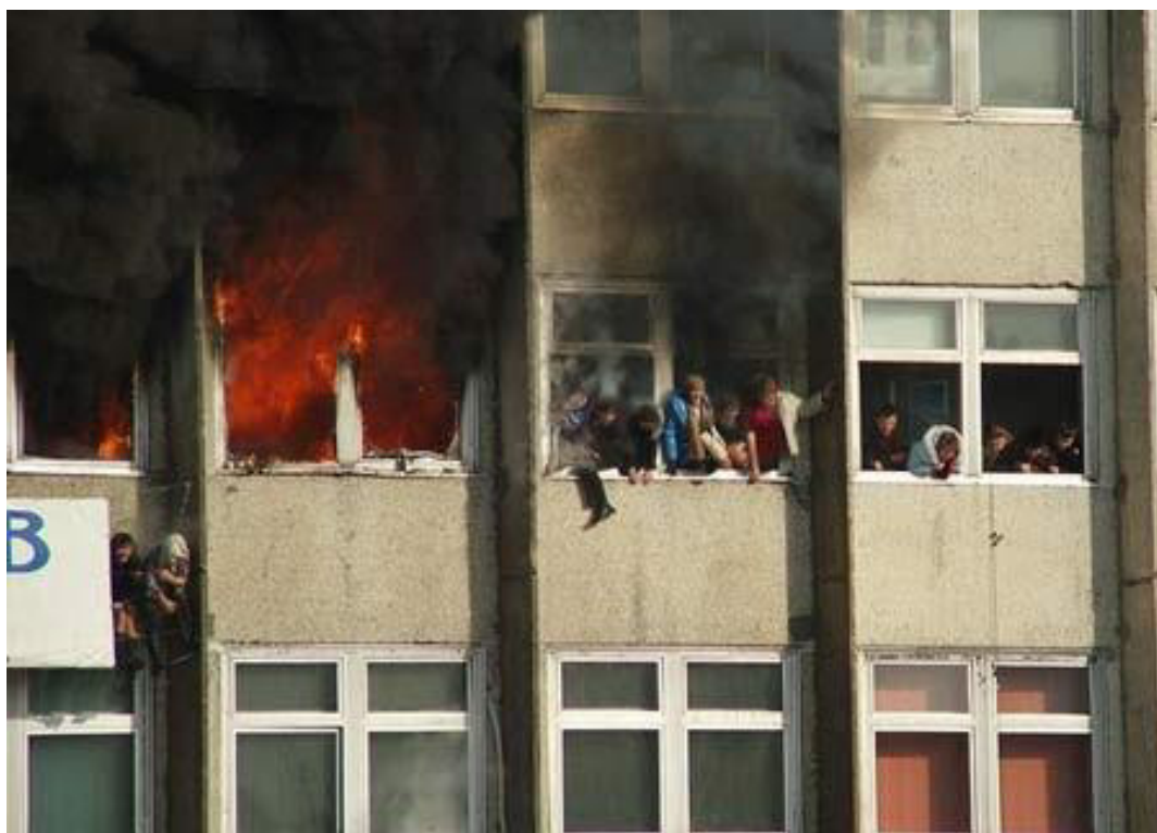
Рис. 1. Пожар в здании «Промстройинипроекта».
