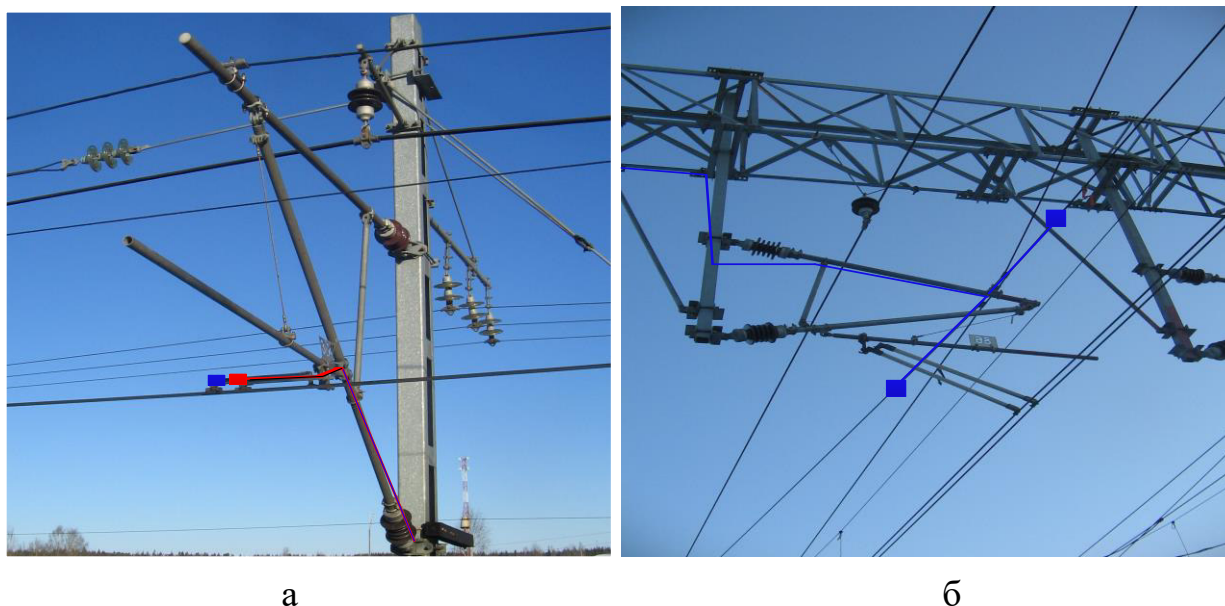
Рис. 1. Предполагаемые варианты размещения датчиков на контактной подвеске: а – датчик нажатия и акселерометр; б – датчик натяжения установленный на средней анкеровке.
