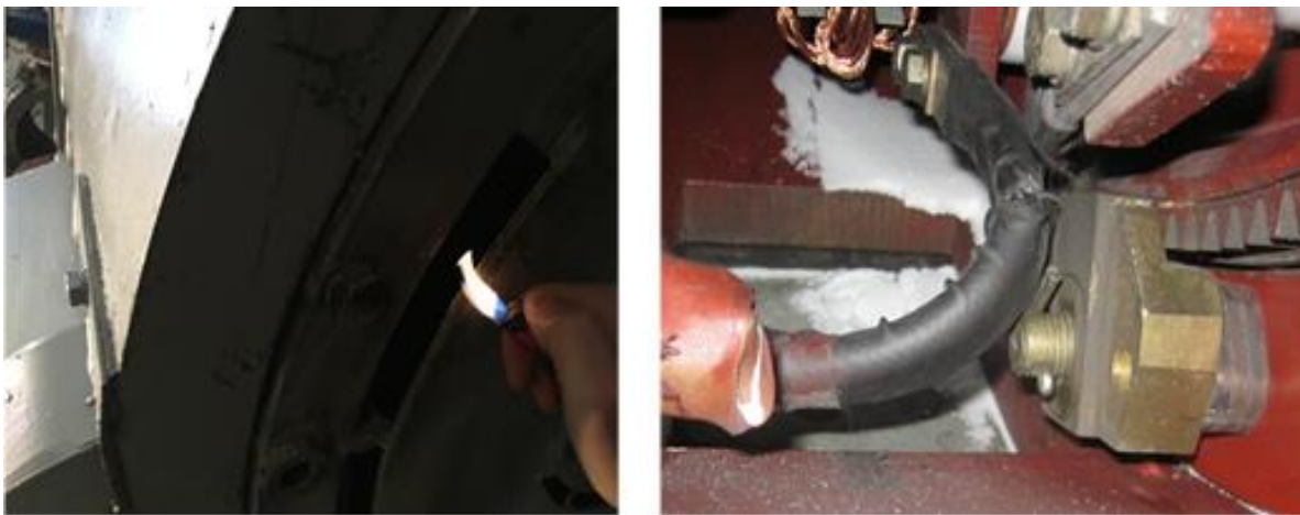
Рис. 2. Попадание влаги в остов тягового электрического двигателя
