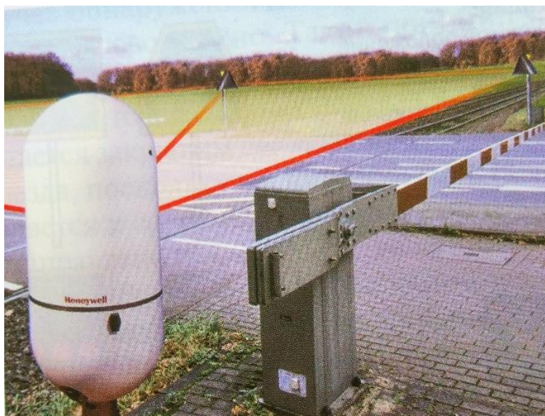
Рис. 4. Радиолокационный датчик компании Honeywell для мониторинга зоны конфликта
