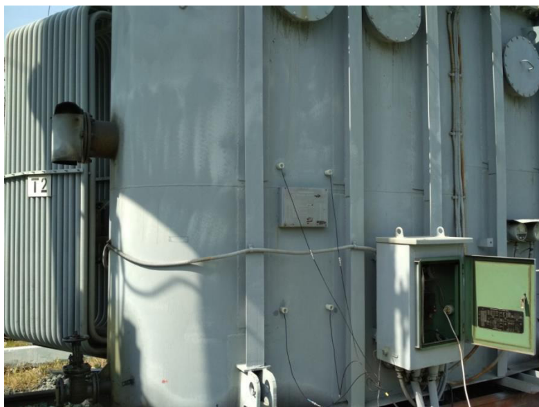
Рис. 2. Установка преобразователей акустической эмиссии
