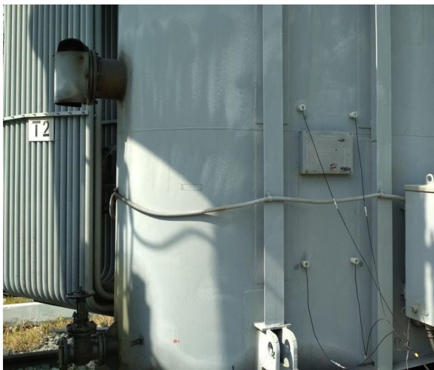
Рис. 1 Расположение датчиков на корпусе трансформатора
