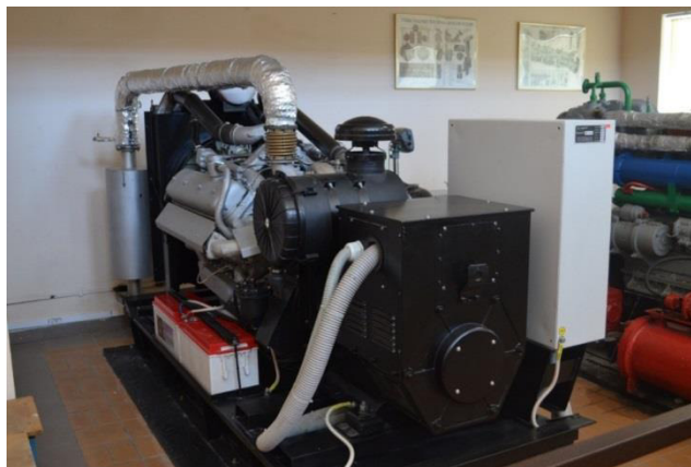
Рис. 1. Конструкция выпускного газохода дизель-электростанции
