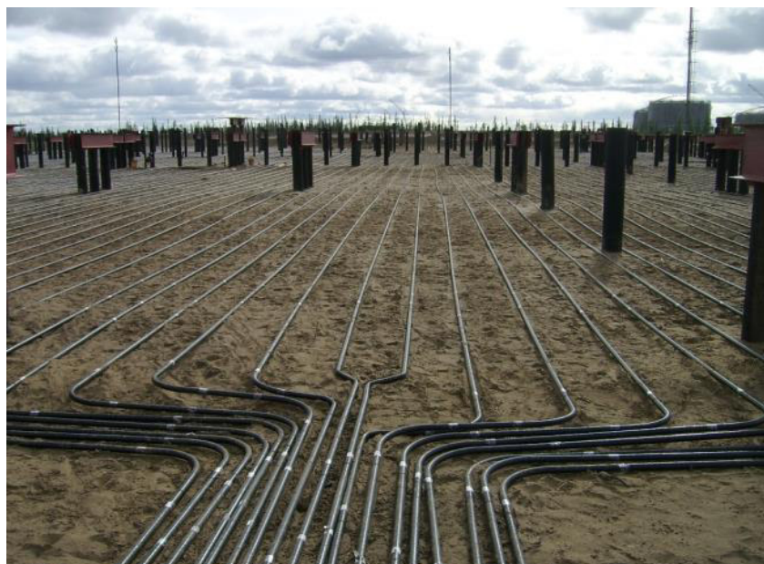
Рис. 1. Общий вид горизонтального грунтового коллектора
