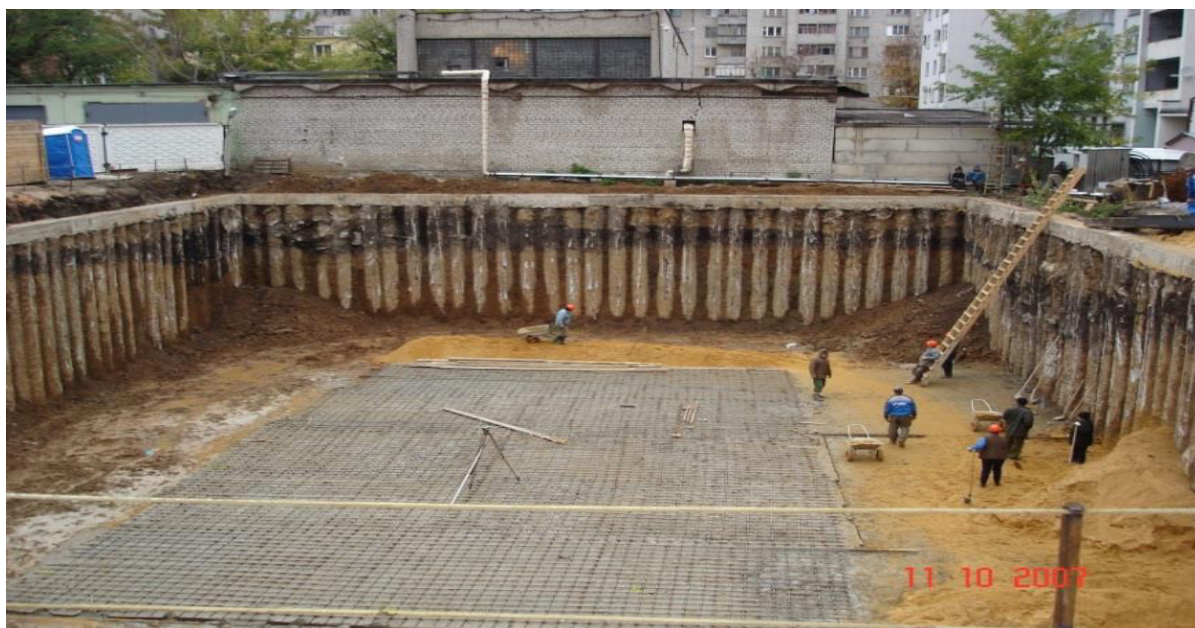
Рис. 4. Общий вид фундаментной стены с тепловыми зондами
