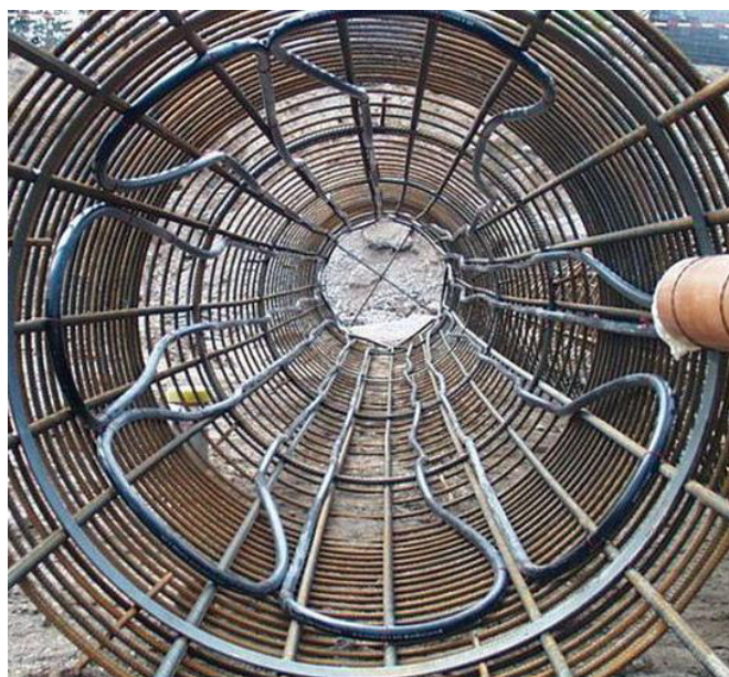
Рис. 3. Общий вид каркаса сваи с тепловыми зондами
