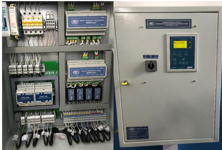
Рисунок 1 – Интеллектуальная система резервирования мощности тяговых подстанций постоянного тока
