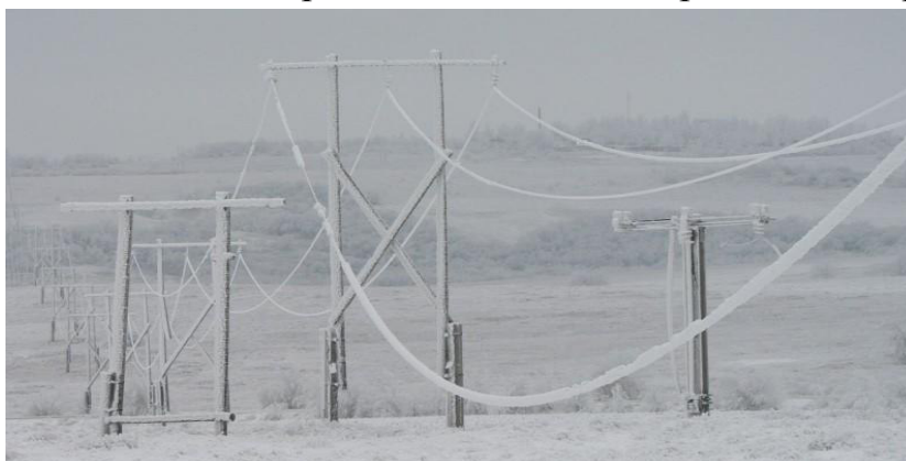
Рисунок 2 – Неравномерное распределение гололёдно-изморозевых отложений по фазным проводам
