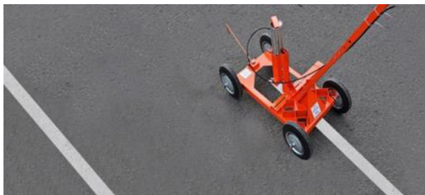
Рисунок 5 – Нанесение разметки дороги
