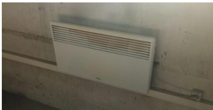
Рисунок 3 – Подключение электроконвекторов гаража и служебно-производственного здания
