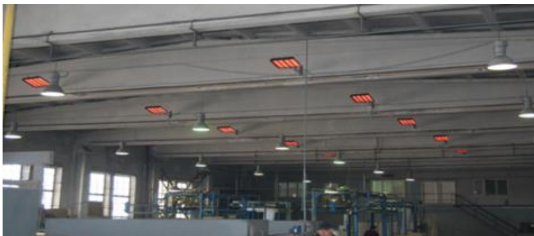
Рисунок 8 – Электрические инфракрасные обогреватели
